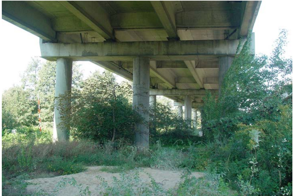
Zwischen Moorburg und Elbtunnel ist die A7 gute 4 km aufgeständert.
